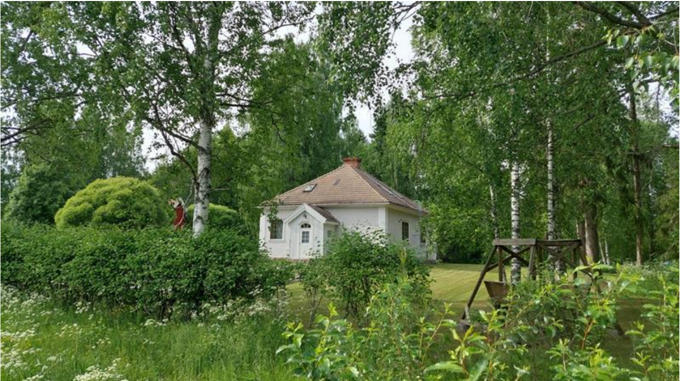
Kuva 26. Yksi Kivisaarentien pohjoispuolen kolmesta asuinrakennuksesta. (Dan Ronimus 06/2022)
