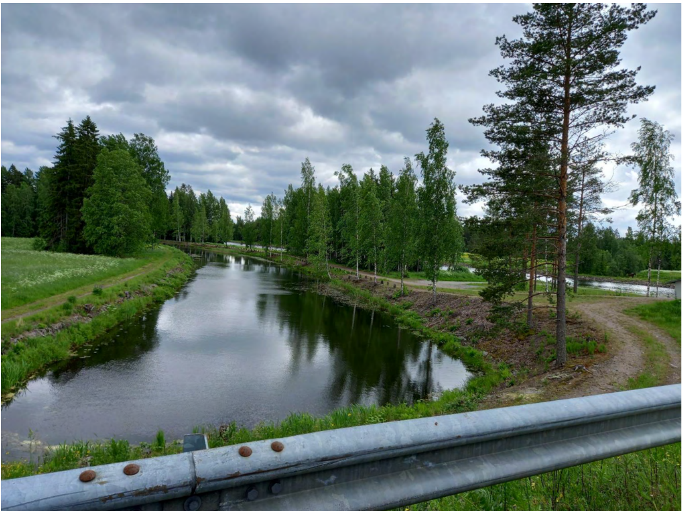
Kuva 33. Vanha ja uusi Saimaan kanava Kansolan kohdalla kesällä 2022. Uusi kanava kuvassa oikealla.
