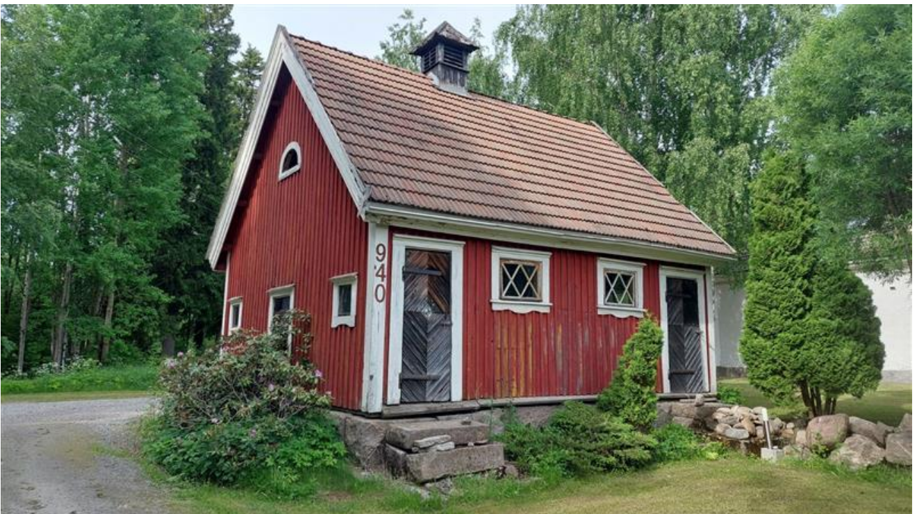
Kuva 27. Yksi kolmesta asuinrakennuksiin liittyvistä talousrakennuksista. (Dan Ronimus 06/2022)
